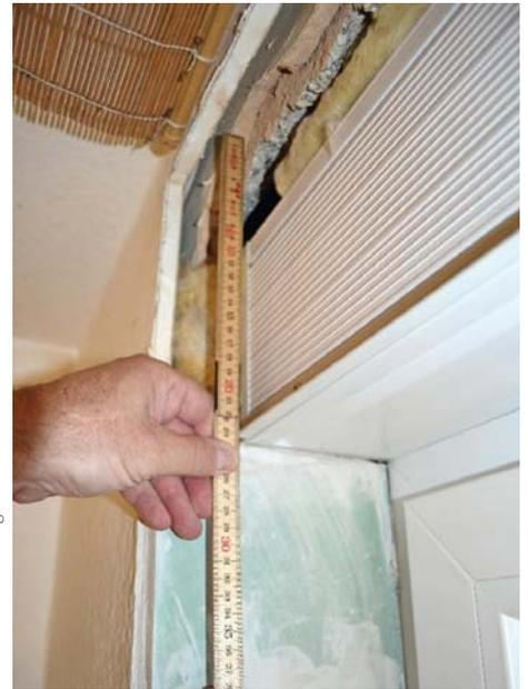
/ Mit Bauschaum-„Befestigung“ lässt sich ohnehin keine Montage nach RC3-Systemvorgaben umsetzen.
